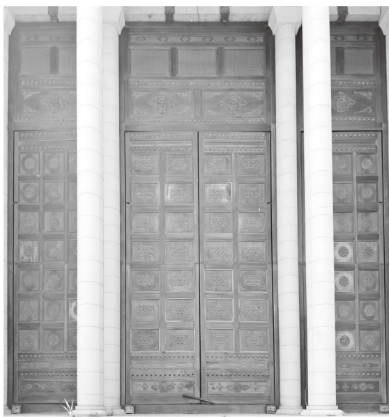
图 5.3 铜门安装实景图
