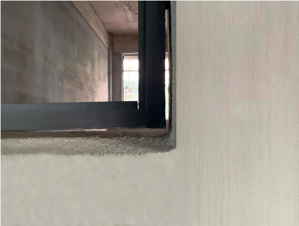
建筑外窗洞口间隙示意图
