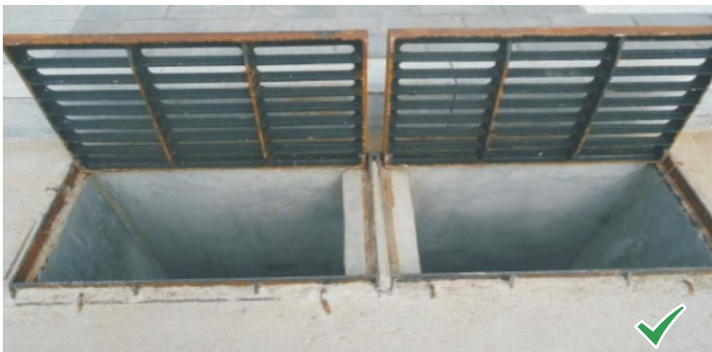
路面排水改造，更换双篦雨水口，提升排水能力
