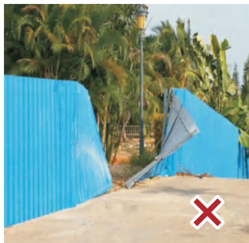
现场作业未设置围挡或围挡封闭不严
