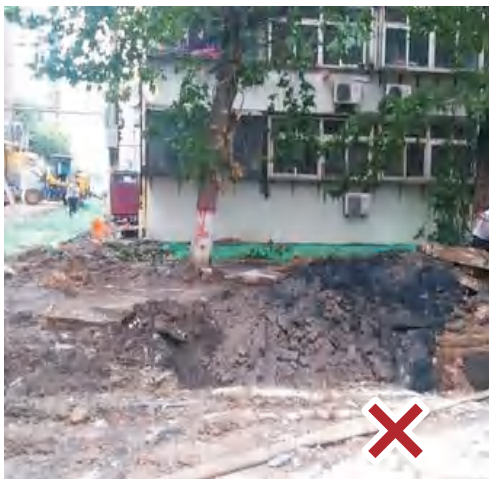
现场作业未设置围挡或围挡封闭不严
