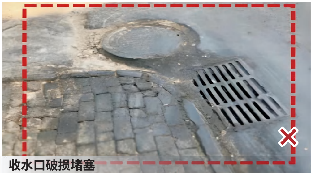
路面排水改造，更换双篦雨水口，提升排水能力
