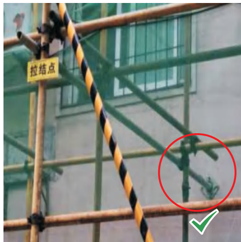
脚手架与建筑物按要求布置拉结点
