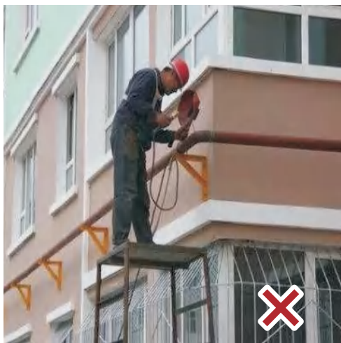
高处作业平台无护栏，未系挂安全带
