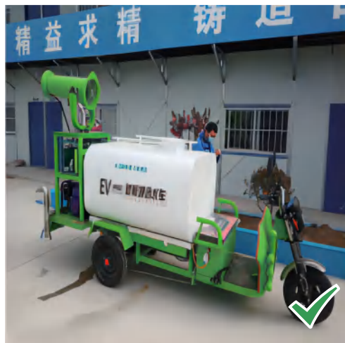
作业时, 采用喷淋洒水降尘措施
