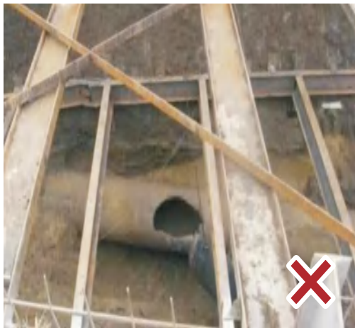
沟槽开挖前未进行管线勘测
