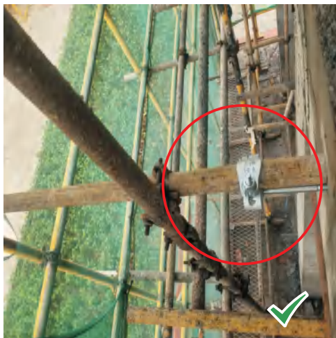
脚手架与建筑物按要求布置拉结点
