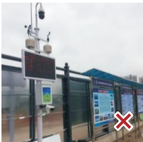
扬尘检测装置位置距离施工区域较远
