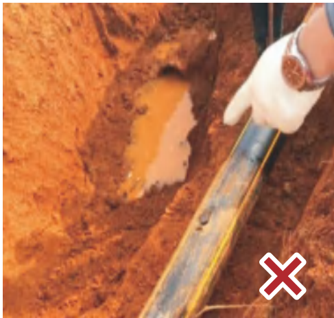
沟槽开挖前未进行管线勘测
