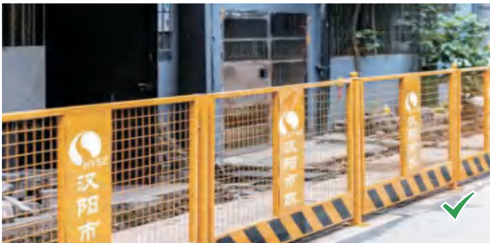
临边高度不足 1.2M 的部位采用网片式防护围栏设置防护
