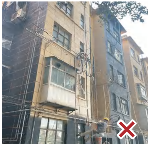
高处作业平台无护栏，未系挂安全带
