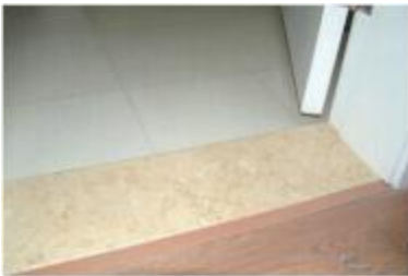
图 1.2.3-3 斜面过度处理实景
