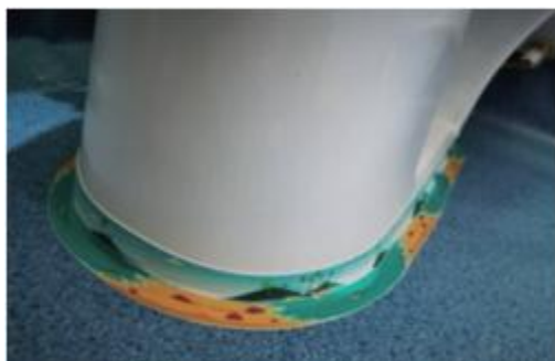
图 1.1.4 马桶周边缝隙处理
