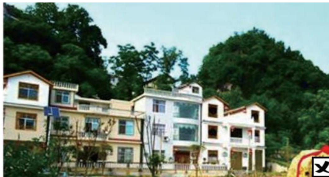
建筑民居墙面不宜大面积进行涂料刷面。
