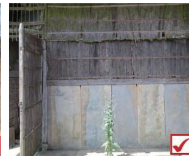
采用当地材料，编草成墙，外埔石板，经济节约，结实耐用且美观大方。
