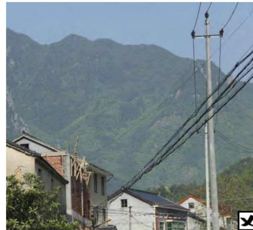
电信设施破坏山村的景观天际线。
