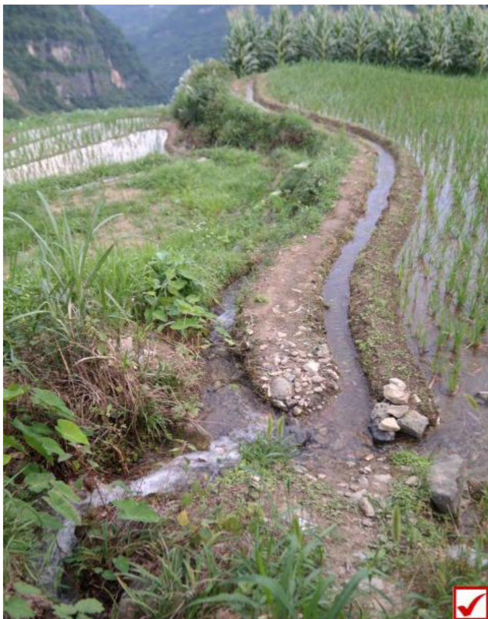
恩施沙地乡倒龙村的水渠。
