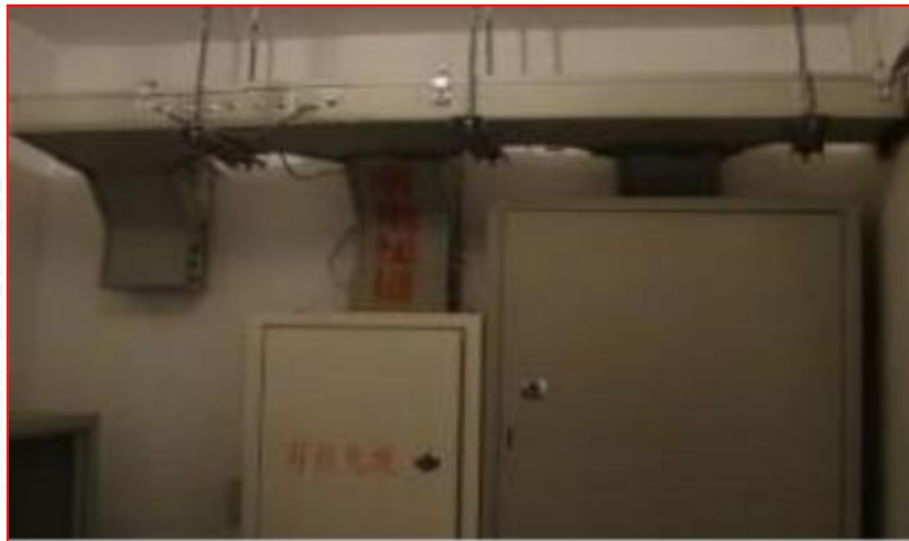
风机房永临结合
