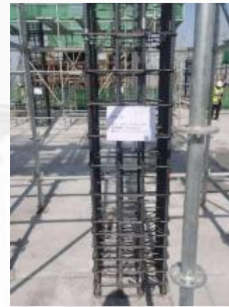
柱钢筋绑扎样板
