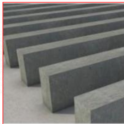
设备基础一体化施工
