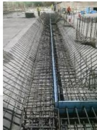
底板施工样板
