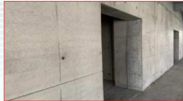
混凝土结构施工样板
