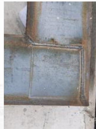
止水钢板焊接样板
